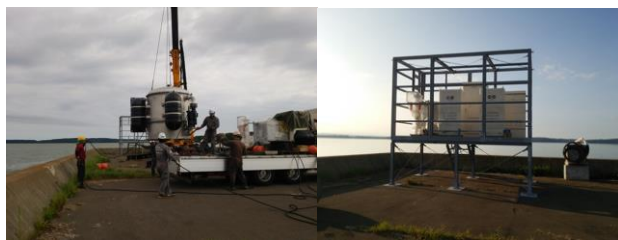
写真-4 試験プラント設置状況 (左: WEP 本体, 右: 陸上施設)
