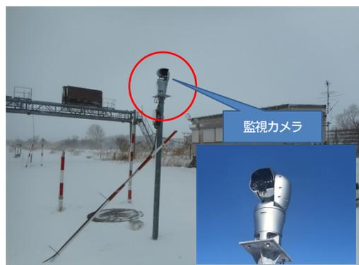
写真-16 監視カメラ設置状況
