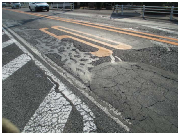
写真2-1 修繕工事現場の路面状況
