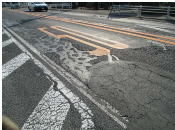
写真 2-1 修繕工事現場の路面状況
