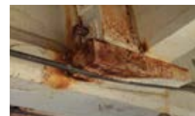
写真-1 偏向部の外観
