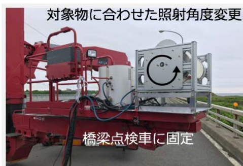
図-2.4 X線源装置の設置状況
