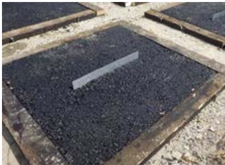
写真3-1 模擬ひび割れ作成
