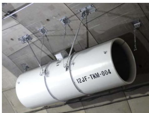
写真-1 JFの設置状況
