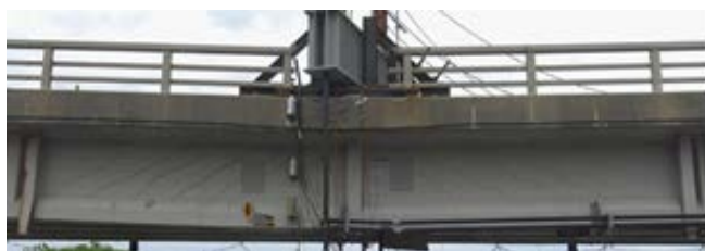
写真-2 載荷点付近の破壊性状
