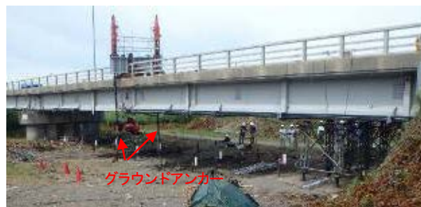
写真-1 載荷径間全景
