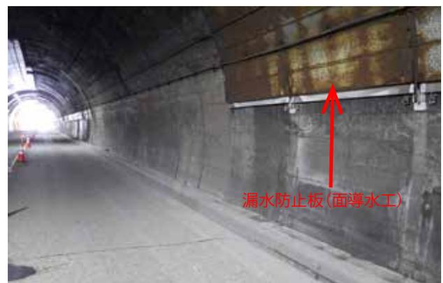
写真-1 漏水防止板施工箇所の状況
