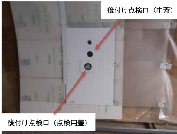
写真-3 後付け点検口設置状況
