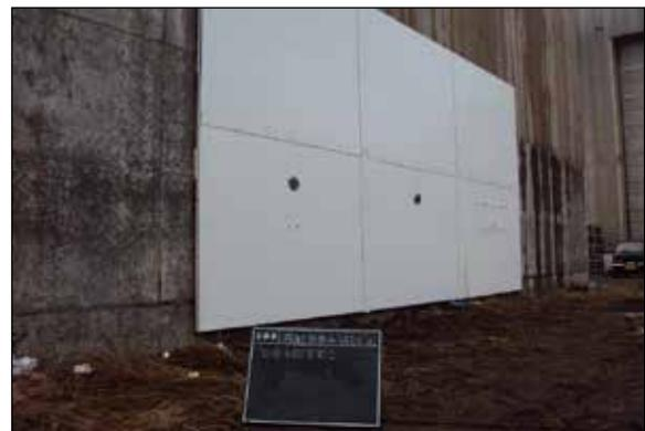
写真-6 断熱漏水防止板設置状況
