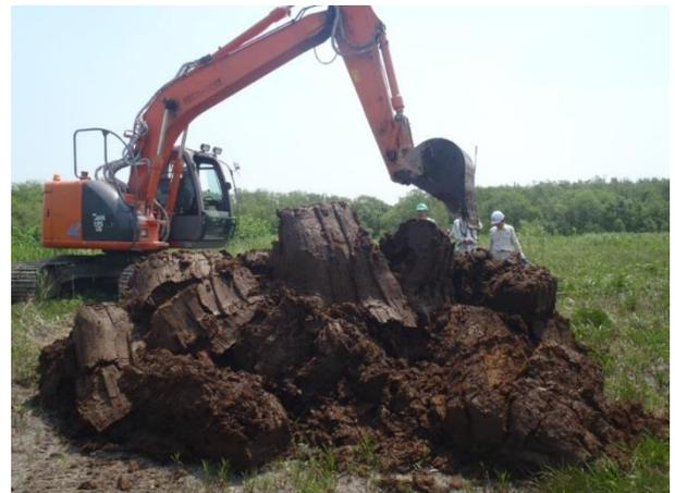
写真-1 北村遊水地での泥炭土採取状況
