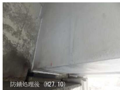
防錆処理後（H27.10） 写真-3.4 D橋 桁端部（海岸部）
