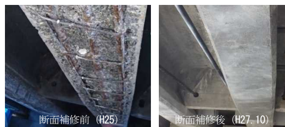
断面補修前（H25） 断面補修後（H27.10） 写真-3.5 E橋 桁下部（内陸部）
