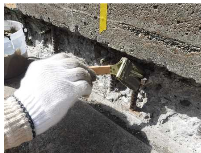
写真-5.3 防錆剤塗布状況
