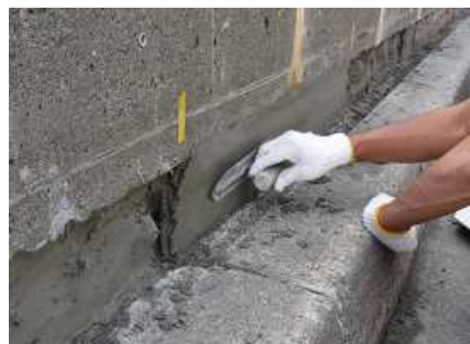
写真-5.4 断面補修状況
