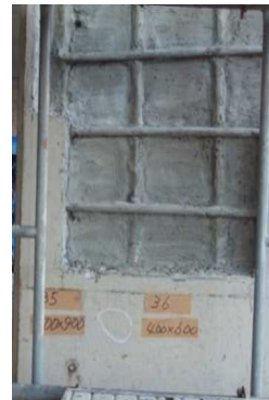
写真-2.2 塩分吸着剤の塗布状況
