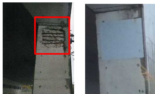
補修前 補修後
