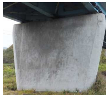
写真-3.2 B橋 橋脚（海岸部）H26.10
