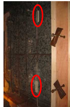
写真-2.3 犠牲陽極の設置状況
