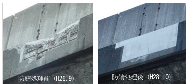
写真-3.1 A橋（都市部）
