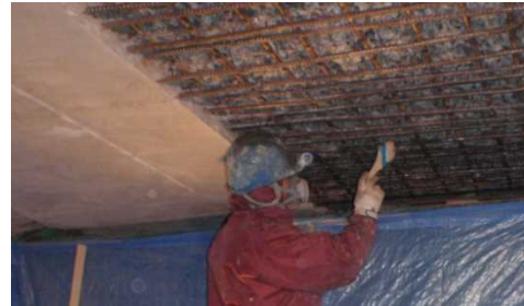
写真-2.1 鉄筋防錆剤の塗布状況
