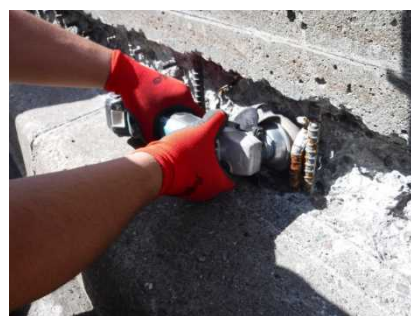
写真-5.1 鉄筋ケレン状況
