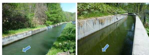
K 幹線用水路 C 幹線用水路 図-37 対象施設の状況
