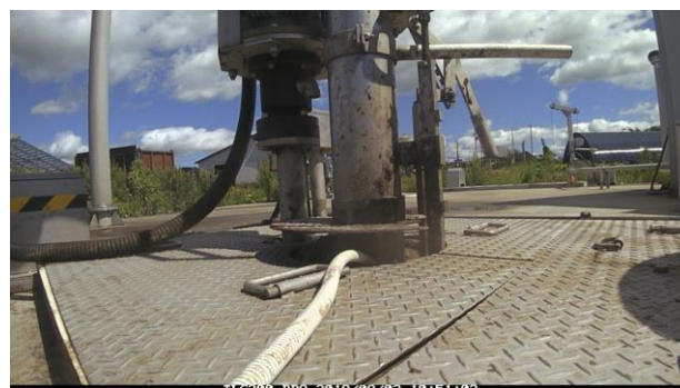
図-25 施設Iでの泡溢流開始直前の状況 (2018/9/2 10:51)
