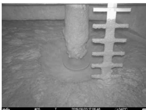
図-37 調整槽内部 (2019/8/3 17:06)
