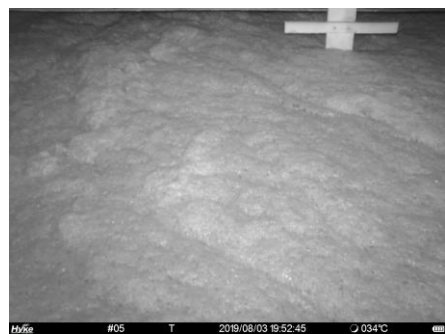
図-32 調整槽内部 (2019/8/3 19:52)
