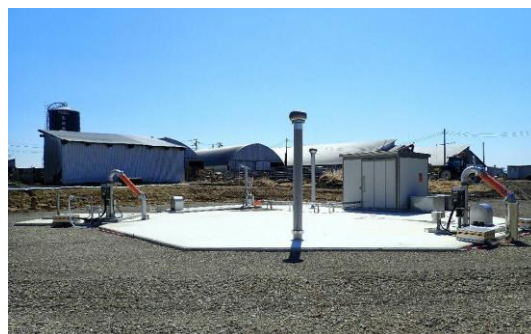
図-20 調査対象施設の外観
