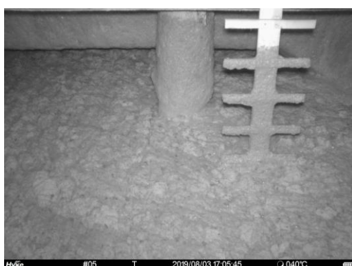
図-36 調整槽内部 (2019/8/3 17:05)
