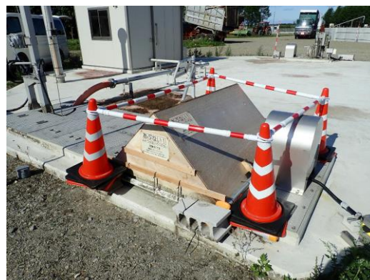
図-21 インターバルカメラ設置状況
