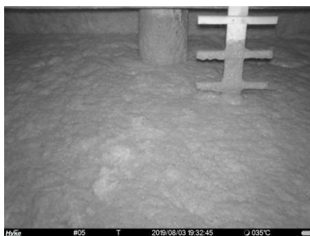
図-31 調整槽内部 (2019/8/3 19:32)
