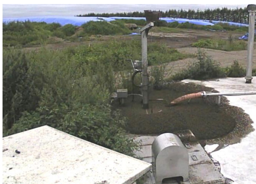
図-22 施設Bでの泡溢流開始直前の状況 (2018/9/4 12:32)
