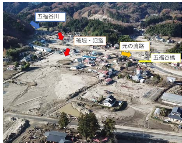
図-4 五福谷川の氾濫状況（2019年12月5日撮影）
