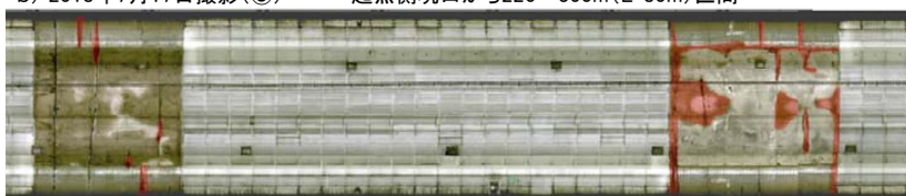
写真-5 トンネル覆工表面を撮影した連続展開画像の例(着色部:面積を求めた漏水の発生箇所)
