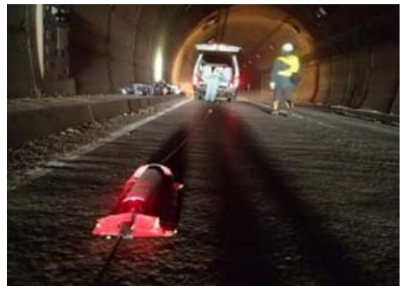
写真-1 トンネル坑内での電気探査の実施状況
