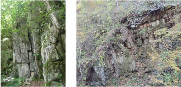
写真-2 露頭におけるゆるみ岩盤の性状例
