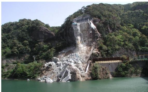
写真-1 ゆるみ岩盤の崩壊
