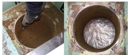
写真-3 \phi 300 掘削状況
