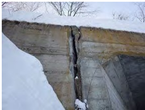
(a) 止水材の劣化・破損および水の流出
