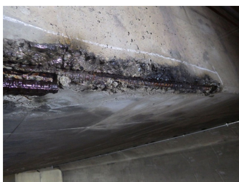
(a) コンクリートのうき・剥離および鉄筋露出
