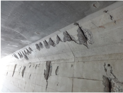
写真-6 うき・剥離のたたき落とし後の様子（例）
