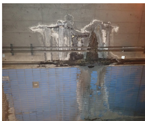
(b) 定期点検2 巡目（令和元年度）
