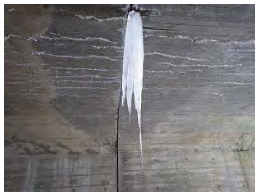
(d) 頂版継手部の氷柱
