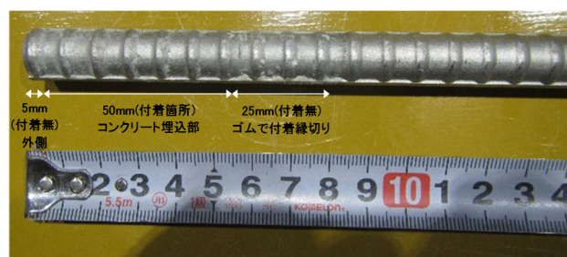
写真-2 コンクリート埋込部の腐食状況 (EL-304)
