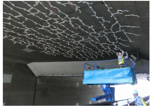
写真-2 ひびわれ補修の例
