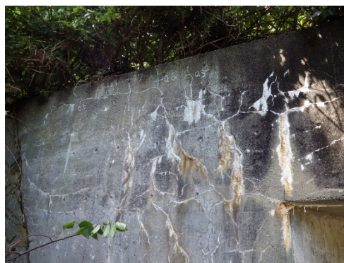
(a) アルカリ骨材反応によるひびわれ
