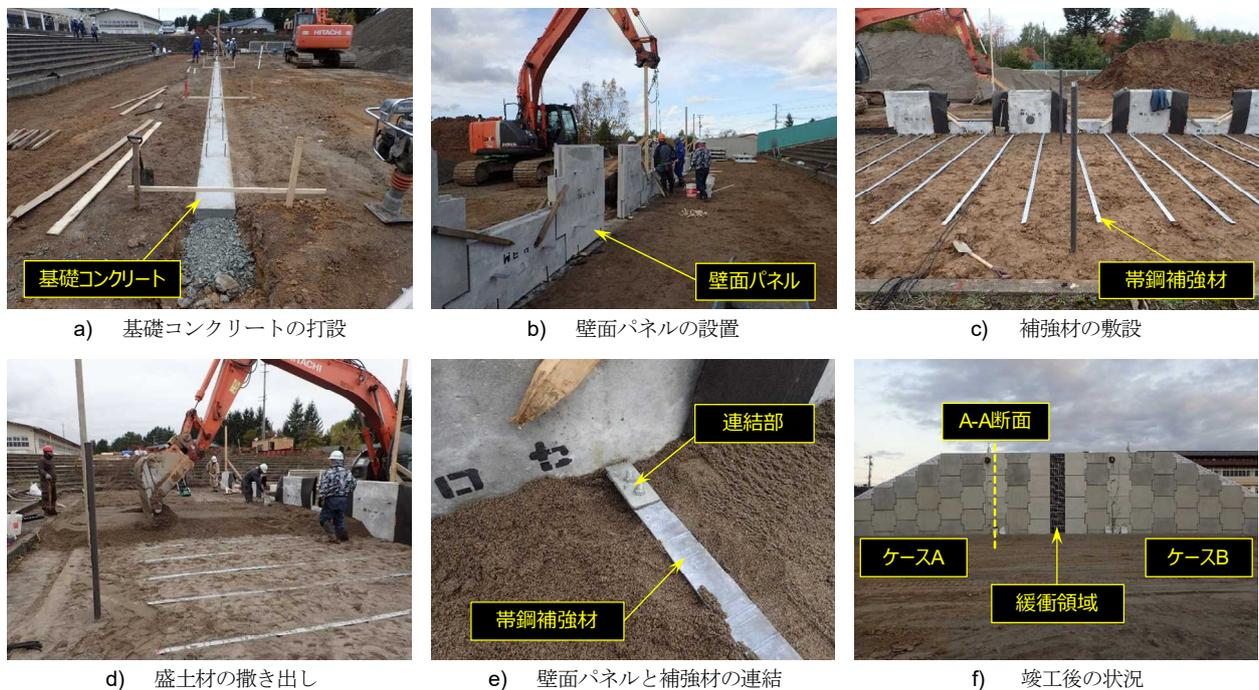
写真-5 帯鋼補強土壁の施工状況
