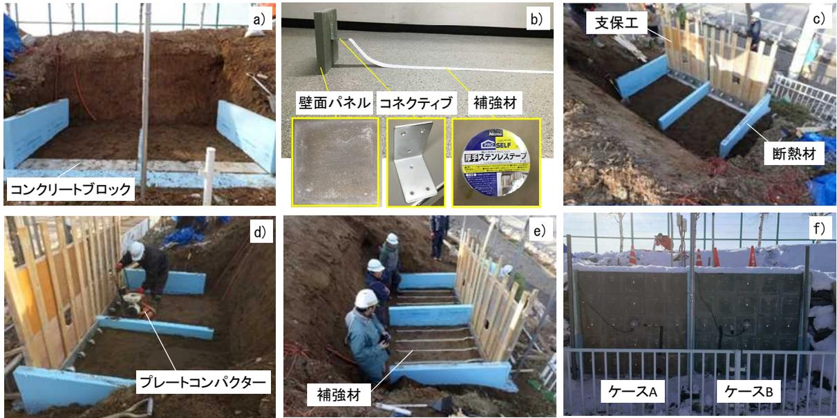
写真-4 屋外補強土壁模型の施工過程
