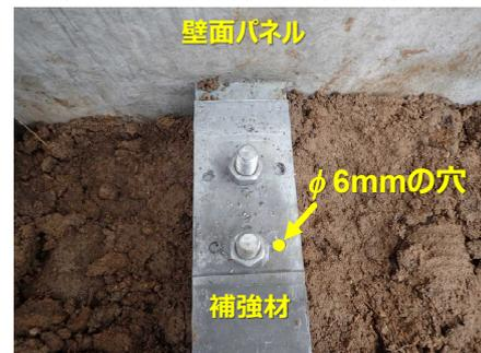
写真-6 断面力低減箇所の連結部の状況
