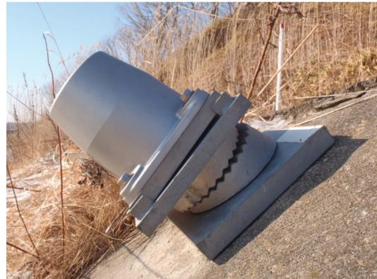
写真-1.1 グラウンドアンカー頭部の変状事例
