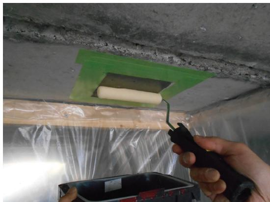
写真-6.3 シラン系表面含浸材の塗布の様子
