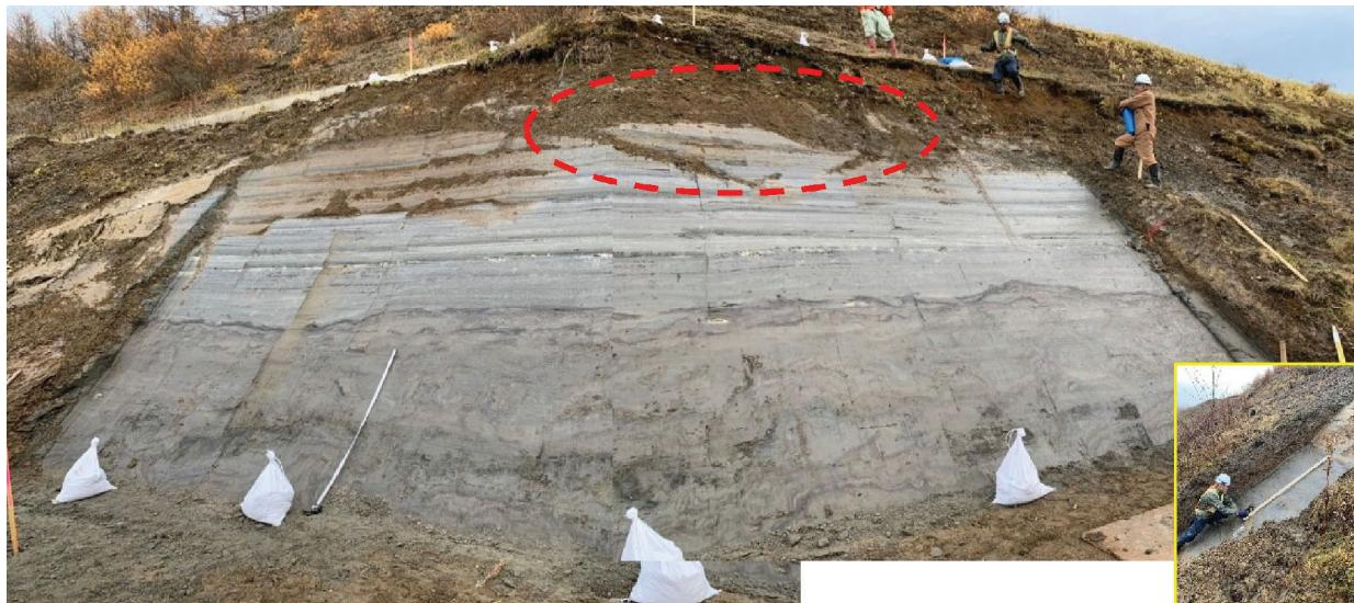
写真-3.3 切土 (1 : 1.2) が完了したシルト岩面の状態 (赤い点線が暗渠排水工の痕跡)
