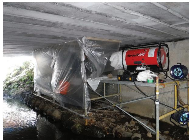
写真-6.2 囲いの設置ならびに加温の様子
