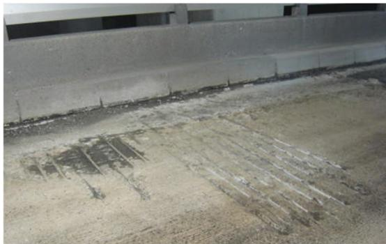
写真-6.1 補装端部からの水分の浸入によるRC床版の損傷例
