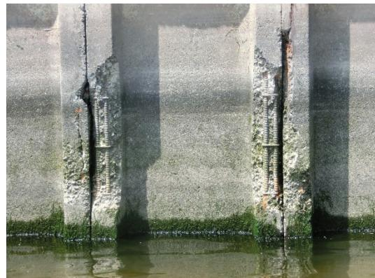
写真-2.2 未補修区間の鉄筋露出状況
