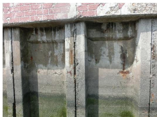
写真-2.5 塩害腐食によるひび割れ
