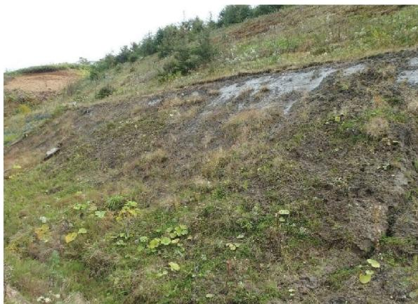
写真-3.1 シルト岩が露出した切土のり面
