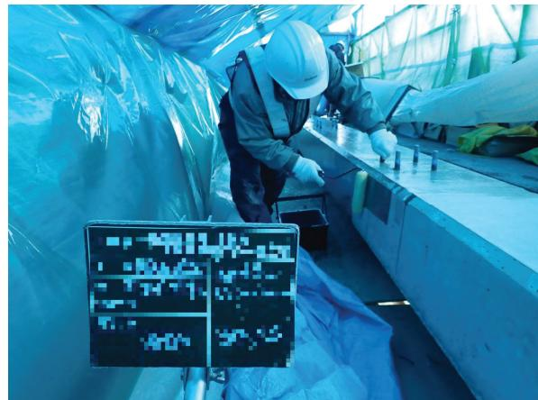
写真-1.1 厳冬期における防寒仮囲い内のシラン塗布状況例（手前の黒板は画像処理を行っている）
