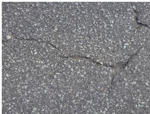
写真-3.7 一冬経過後のひび割れ部の状況
