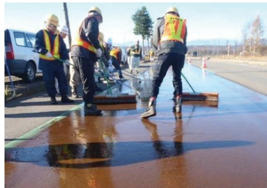
写真-3.5 ブラシ・レーキによる乳剤の擦り込み作業
