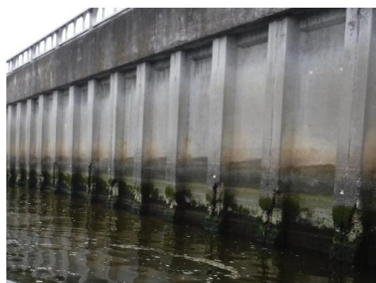
写真-2.1 未補修区間のコンクリート剥離状況
