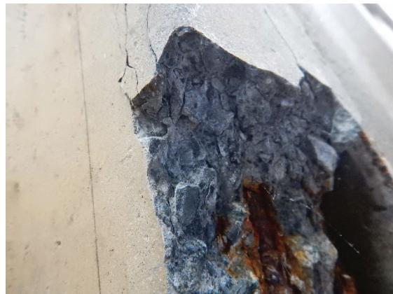
写真-3.4 現地構造物の脆弱化部の一例
