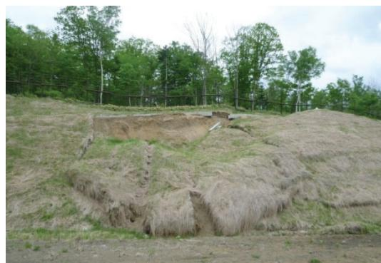
写真-1.2 凍上に起因する切土のり面崩壊
