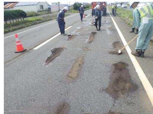
写真-3.8 乳剤散布直後に砂散布および擦り込みを行っている様子
