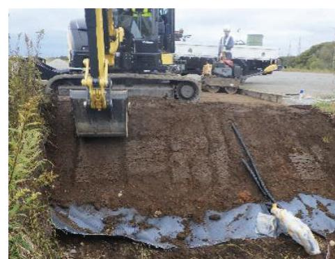
写真-4.2 WF排水材試験施工状況
