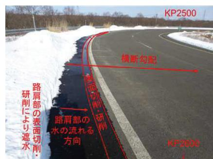
図-3.4 流入遮断性能の確認
