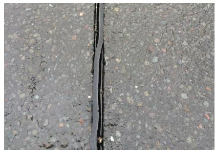
写真-10.1 供用後に発生した目地部の隙間
