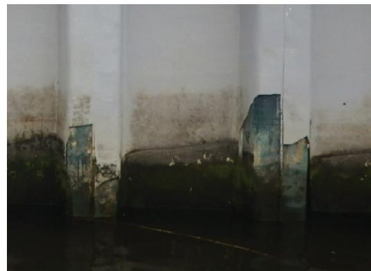
写真-2.6 保護モルタルの剥落状況
