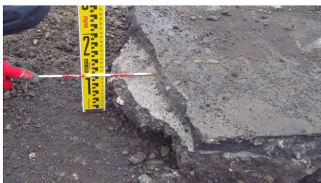
写真-2 表層に付着した固化したアスファルト再生路盤
