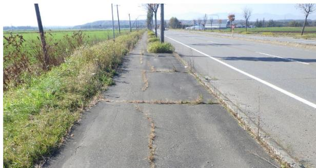
写真-3 歩道の凍上ひび割れおよび低温ひび割れ
