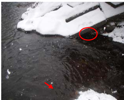
写真-5 護岸の背後の越冬場所 NO1 (表-3 参照)
