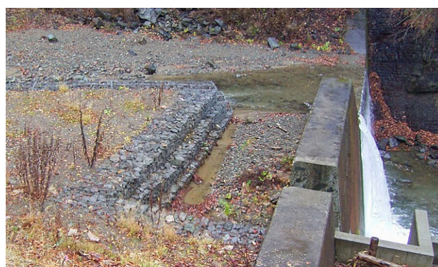
写真-7 魚道上流部土砂堆積状況
