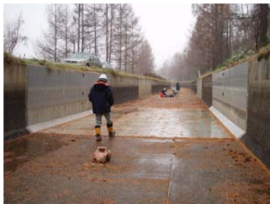
写真-5 落水後の目視調査状況
