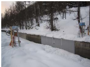
写真-4 試験施工区間における冬の観測状況
