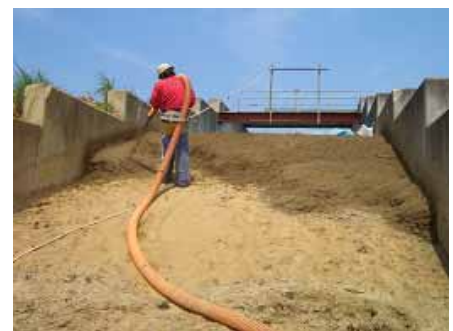
写真－1 堤防裏のり面被覆の施工状況
