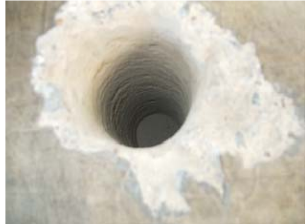
写真-5 ジャックハンマによる削孔後
