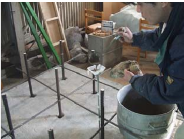
写真-8 グラウト注入の様子
