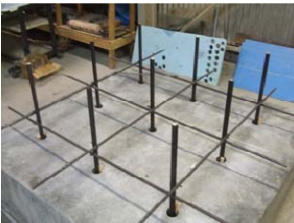
写真-7 補助筋配置
