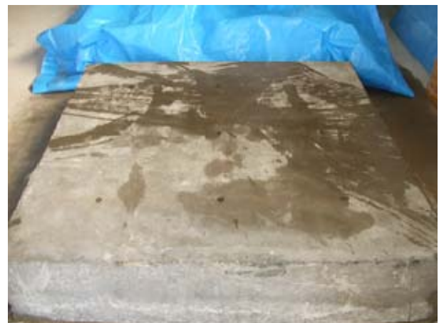
写真-1 周辺コンクリート硬化後
