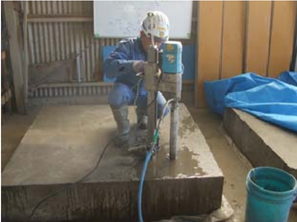
写真-2 コア抜き状況
