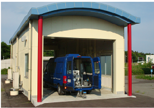
写真-1 土木研究所に設置した「FWD 検定施設」
