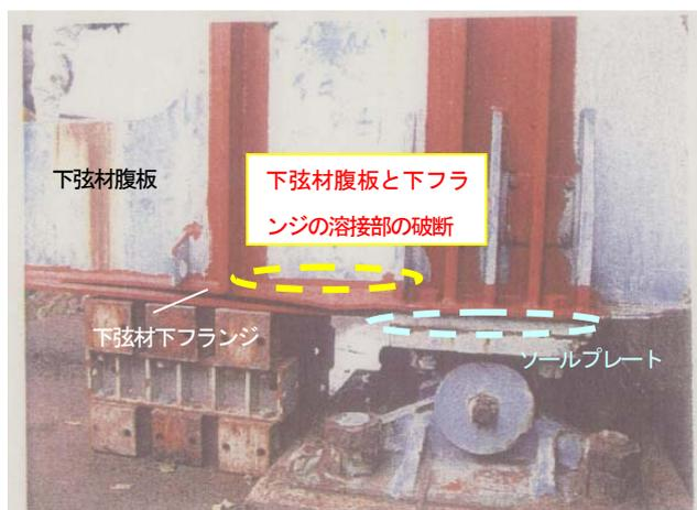
図2.6 A2固定支承付近の補強後の状況
