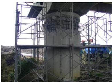
図2.8 損傷の大きかったP5橋脚
