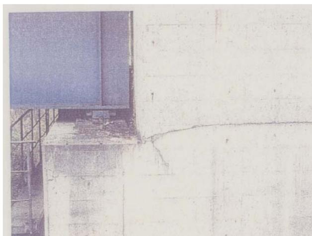
図 2.3 上り線かけ違い橋脚 P1 上パラペット基部に生じたひび割れ
