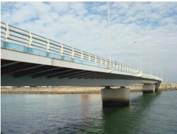
写真-1 A橋の全景
