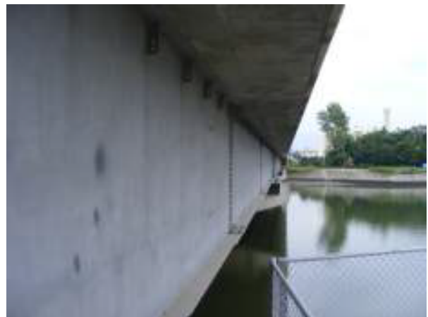
写真 - 6 外桁の腹板の状況
