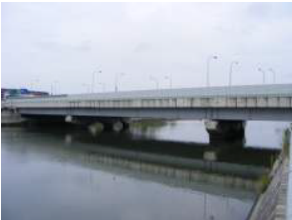
写真 - 5 B 橋の全景
