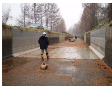
写真-4 落水後の目視調査状況
