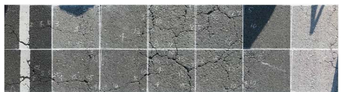
図-8 図-7 と同区間における静止画像 (デジタルカメラ)
