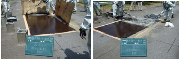
アスファルト乳剤散布
