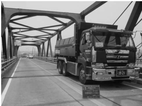
図-9 影響線荷重実施状況
