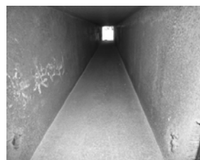
(c) 箱断面部材密閉内部
