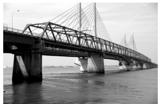
図-2 撤去前の鋼トラス橋（手前）と新橋（奥）
