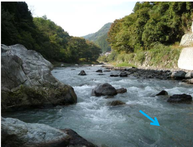
写真-4.1 点在する巨礫の状況（下久保ダム上流）
