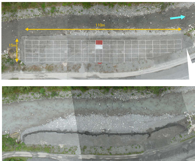
図-2.2 置土の空中写真 (上：置土侵食前、下：置土侵食後)
