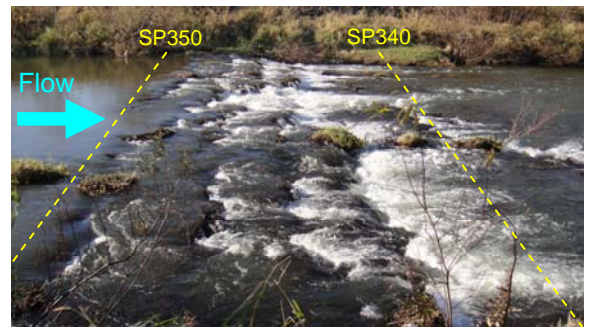
図 - 15.1.26 堰上下流区間 (H22.3)
