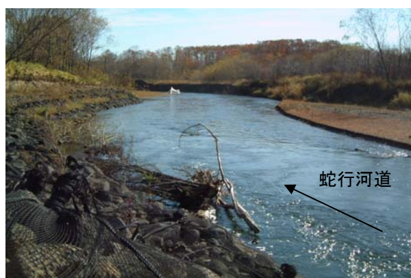
図 - 15.1.12 護岸設置状況（H14.11）
