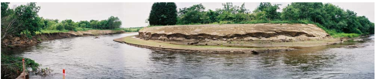
図 - 15.1.9 蛇行河道：局頂部内岸側および外岸側の河岸浸食状況（平成 14 年 7 月：大規模洪水前）
