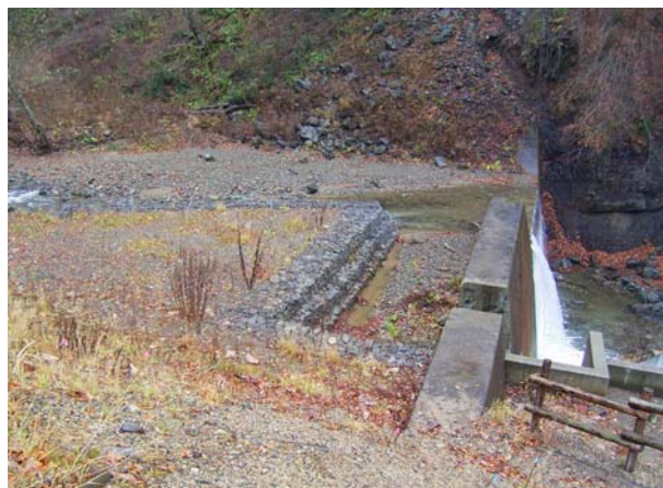
写真-1 魚道上流部の状況(護岸工を設置するも土砂が堆積している様子)
