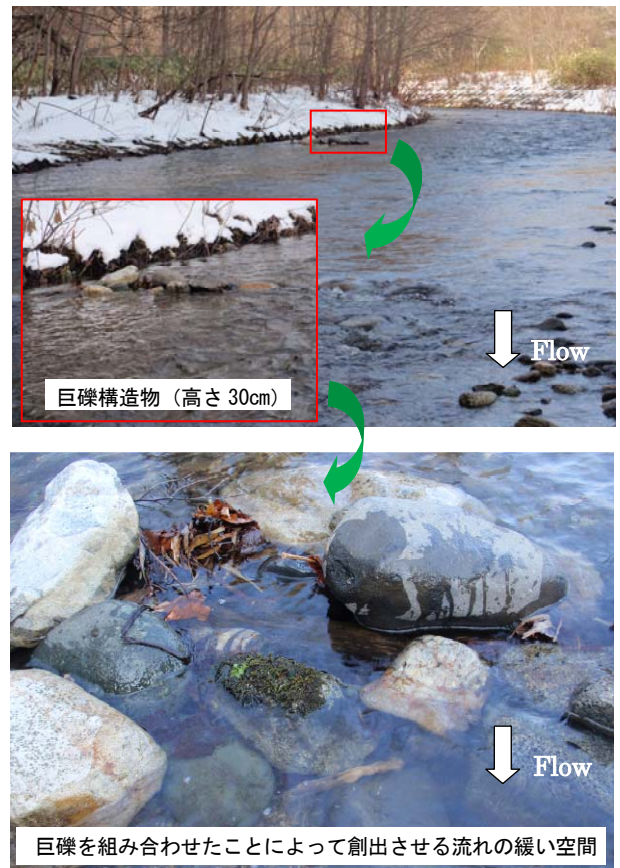
図-6 設置した巨礫構造物の様子
