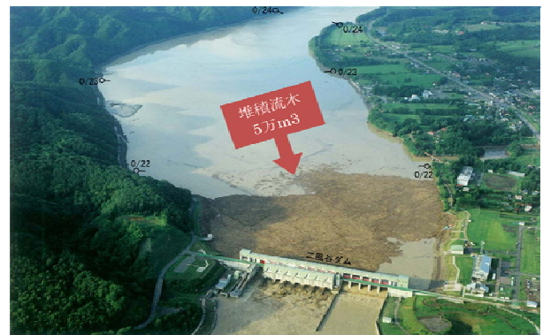
図-15.5.1_二風谷ダム流木集積状況(2003.8)
