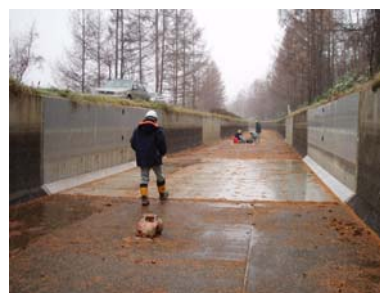
写真-4 落水後の目視調査状況
