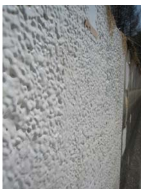
写真-6 劣化部除去面にウレタン樹脂を塗布した水路
