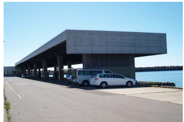
写 1-3 久遠漁港 屋根付岸壁
