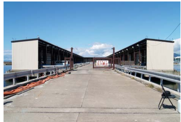
写 1-2 室蘭港 屋根付岸壁
