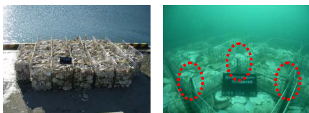
写真-5.2 実用化に向けて規模を拡大した貝殻礁 左側：貝殻礁全景 右側：設置状況（丸印が採水パイプ）
