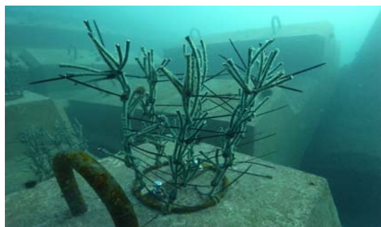
写真-4.1 人工海藻の設置状況 2009年11月
