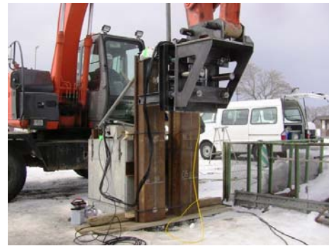
写真-5 動作確認試験、超音波探傷確認試験
