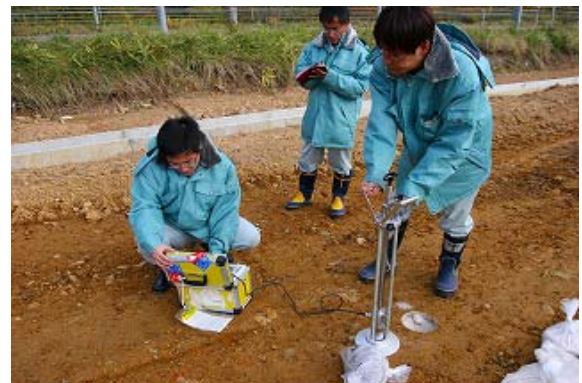
写真-2 盛土の衝撃加速度測定
