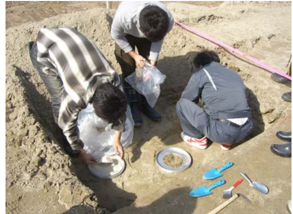
写真-1 砂置換による盛土の密度測定
