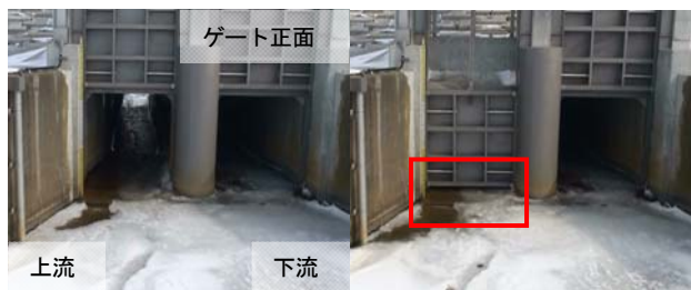
閉操作前(11:21) 閉操作後(11:27) 写真-2 鶴川B樋門：引上げ式ローラーゲート(H21.2.27) ※赤枠：不均一な結氷により生じた開口部
