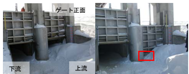
写真-7 十勝 B 樋門：引上げ式ローラーゲート (H21. 2. 23)
