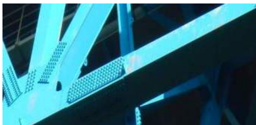
写真-12 塗装で補修後6年 (G橋梁)
