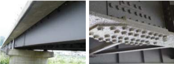
a) 湿気のこもらない桁外面 b) 湿気のこもる桁内面 写真－3 湿気の影響の有無
