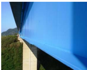
a) 外桁外面 写真-10 塗装で補修後10年 (E橋梁)
