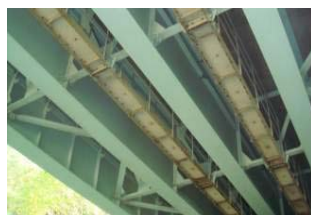
写真-11 塗装で補修後5年 (F橋梁)
