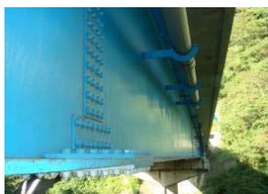
写真-11 塗装で補修後5年 (F橋梁)
