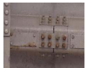
b) ボルト部
