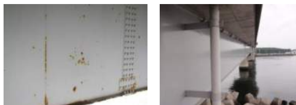
a) 塗替え塗装前 b) 塗替え塗装後3年 写真-7 塗替塗装前後の状況 (B橋梁) (素地調整程度1種)
