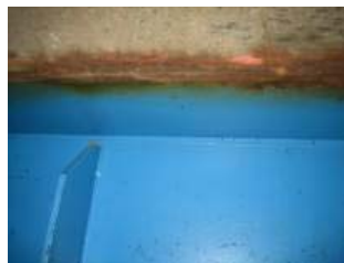
a) 外桁外面 写真-10 塗装で補修後10年 (E橋梁)
