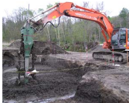
写真2 トレンチャー式混合処理工法
