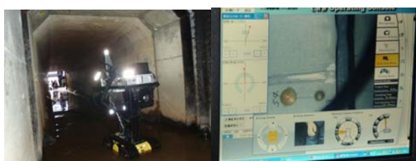
写真13 試験状況(左側:自走装置で函体内の測定を計測、右側:自走装置の操作パソコン画面で測定鉞を確認)
