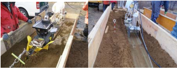
写真9 堆砂除去試験状況 (左側：除去中、右側：除去後)
