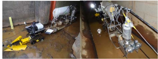
写真10 実樋門試験状況
