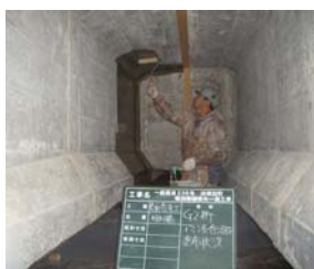
写真-3.2 塗布状況
