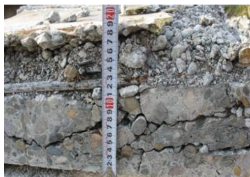
写真-1 A 橋の試験体切断図
