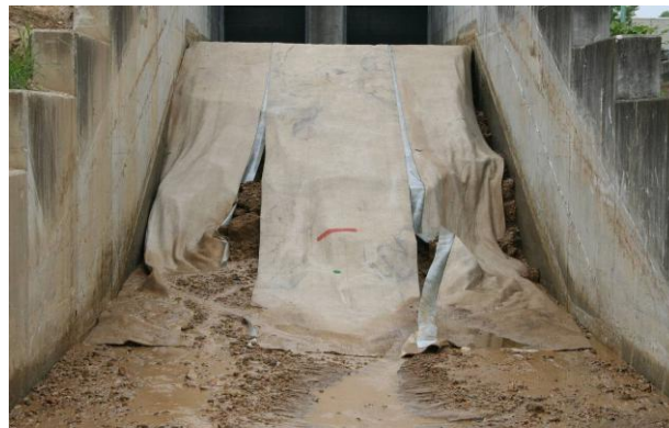
写真-2 遮水シートによる越水対策実験
