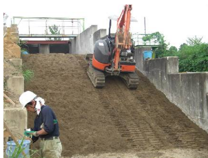
写真-6 短繊維混合土被覆工の施工状況（機械転圧）
