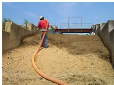
写真-3 短繊維混合土被覆工の施工状況(吹付け)
