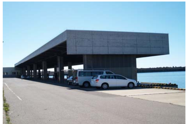
写真4-3 久遠漁港 屋根付き岸壁
