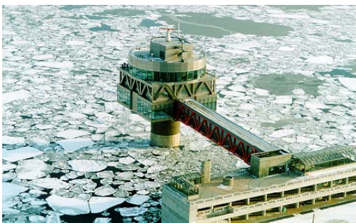
図-6.3(c) 水面付近のコンクリート表面をチタンクラッド鋼で保護 (オホーツクタワー)
