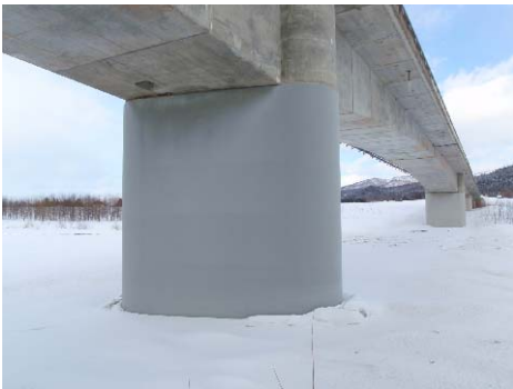
図-6.3(b) 鋼板が取り付けられた橋脚 (天塩川)
