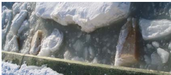
図-6.19 錆が付着した流氷（損耗が著しいオホーツク海に面した矢板近傍）
