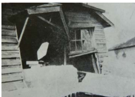
図-1.2 流氷を伴った津波による被害例
