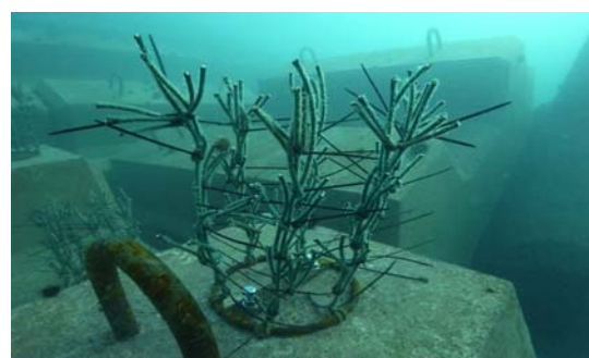
写真-5.1 人工海藻の設置状況 2009年11月
