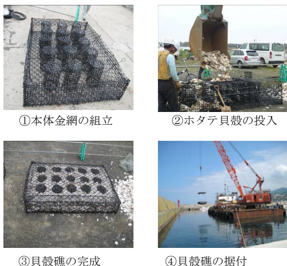
写真-6.3 実用型の貝殻礁の製作・据付状況
