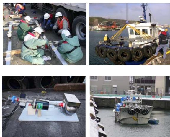
写真-5 艀装用架台組立(左上)、架台設置(右上)、機器取付(左下)、撮影計測(右下)
