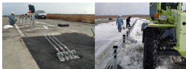
図 15 試験施工と除雪作業に伴う支柱への影響の確認
