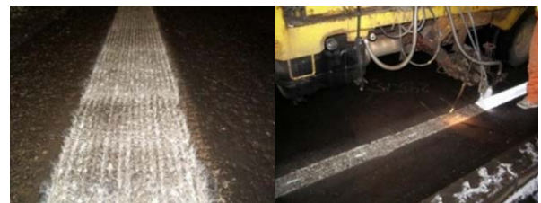
図9 切削型区画線の施工状況
