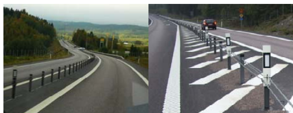
図 13 ワイヤロープ式防護柵 (スウェーデン)
