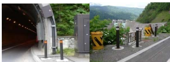
図 12 衝撃吸収型ポラードの設置状況
