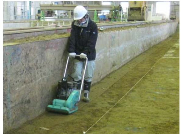
写真-9 締固め状況
