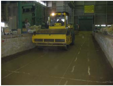
写真-4 締固め回数試験状況
