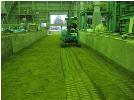
写真-5 初期締固め状況
