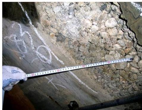
写真-1 骨材が露出している変状例
